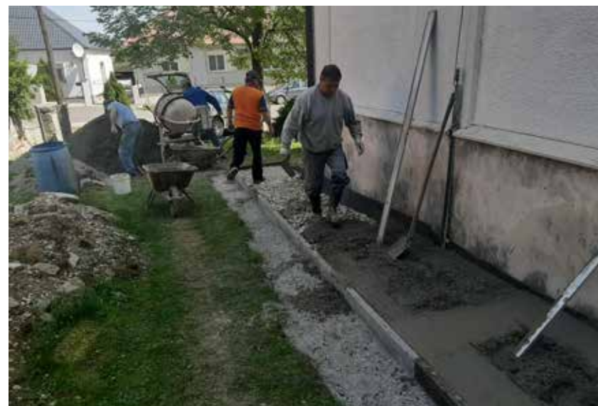
A nárai Kurcz Ernő készítette a szigetelést és a vízvezető betonjárdát. Segítői (balról) Pető Gábor, Taller Zoltán és Horváth Zoltán voltak
