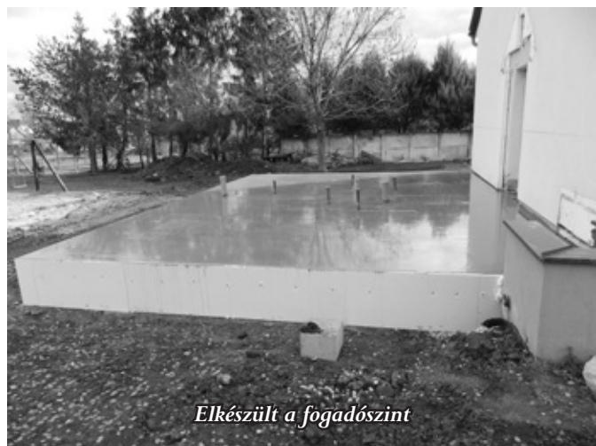
Fogadósint betonozása
