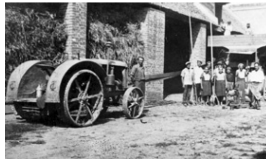
A kép az 1940-es évek elején készült Náraiban az Eörrsy portán. A cséplőgépet munka közben ábrázolja, amelyet az angol gyártmányú traktor hajtja.
